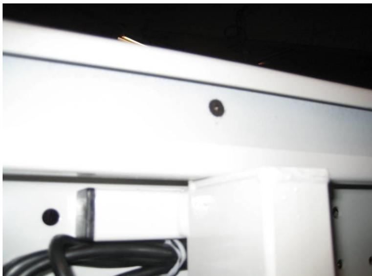
Bohren Sie und befestigen Sie das C-Profil an seinen Halterungen. Denken Sie daran, Senkschrauben zu verwenden!
